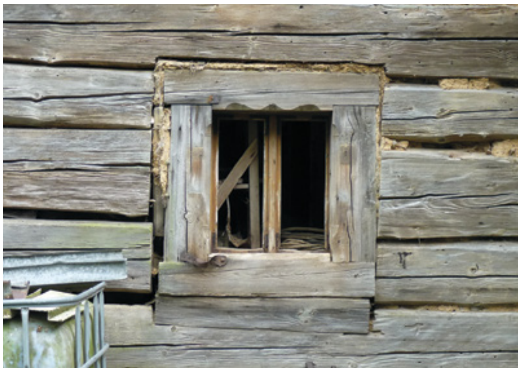
5. Okno světnice roubeného domu s masivní zárubní v severozápadním průčelí, 2015, foto Z. Křenková. Window of the timbered house sitting room with a massive frame in the north-west facade. Stubenfester mit massiver Fens-terrahmung in der nordwestlichen Fassade des Blockhauses.
