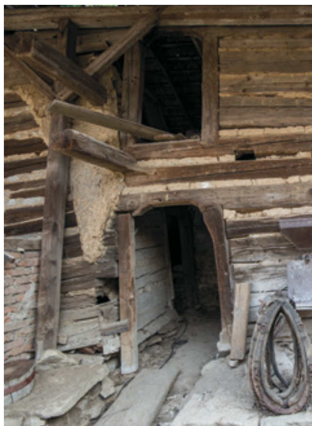
10. Dvojice sedlově zakončených portálů roubeného vstupu, 2015, foto J. Kmošek. Pair of gabled portals of the timbered entrance. Zwei Schulterbogenportale vom gezimmerten Eingang.
