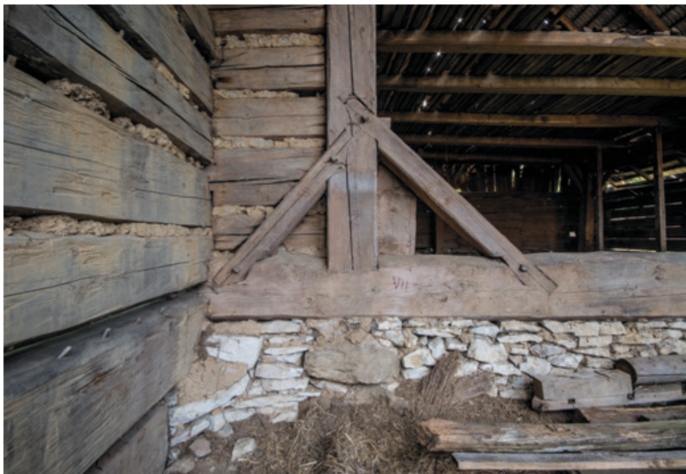
33. Detail tesařských spojů sloupku u severní stěny stodoly, 2015, foto J. Kmošek. Detail of carpentry joints of a post by the northern wall of the barn. Detail der gezimmerten Verbindungen von der Säule an der Nordwand der Scheune.
