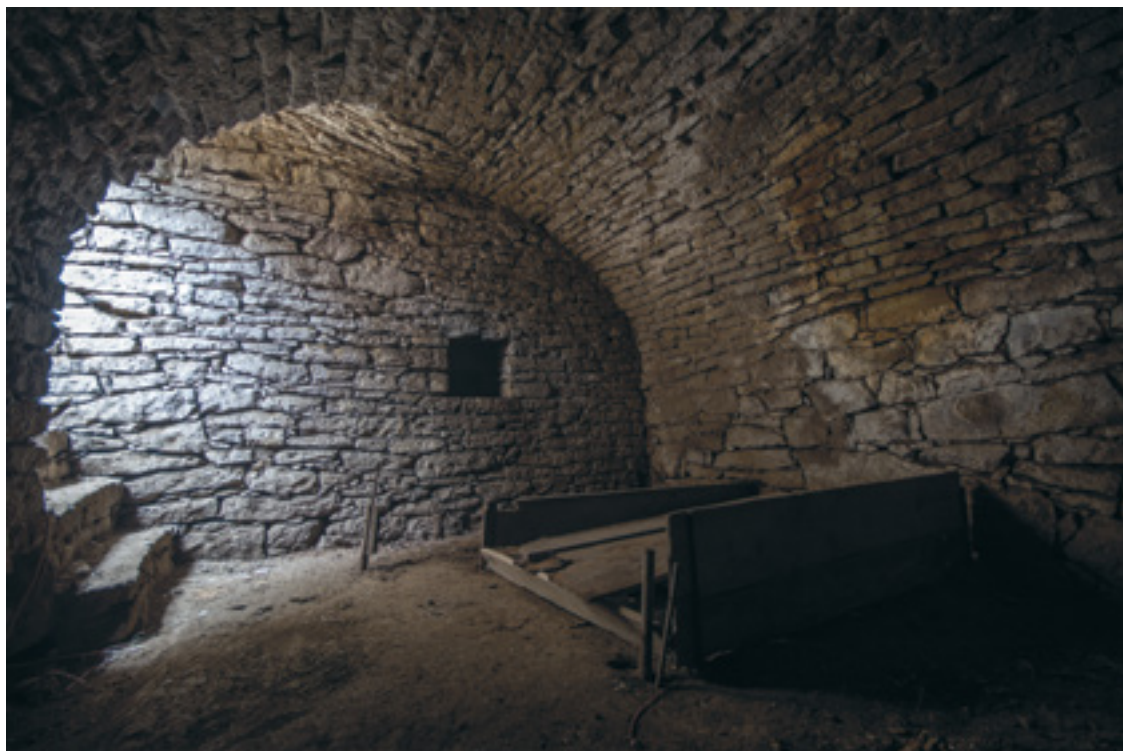
18. Sklep pod roubeným domem se schodištěm do síně, pohled k severovýchodu, 2015, foto J. Kmošek. Cellar under the timbered house with the staircase into the hall, view towards northeast. Keller unter dem Blockhaus mit Treppenhaus in den Flur, Blick zum Nordosten.
