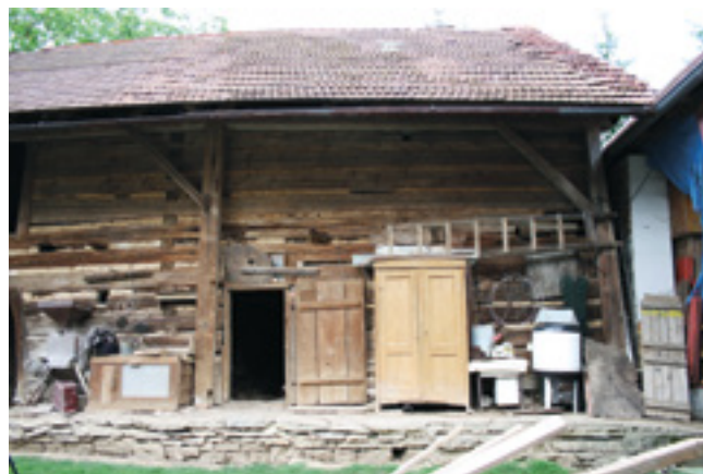
9. Detail jihozápadního průčelí roubeného domu, 2015, foto V. Říhová. Detail of the south-west facade of the timbered house. Detail der südwestlichen Fassade des Blockhauses.
