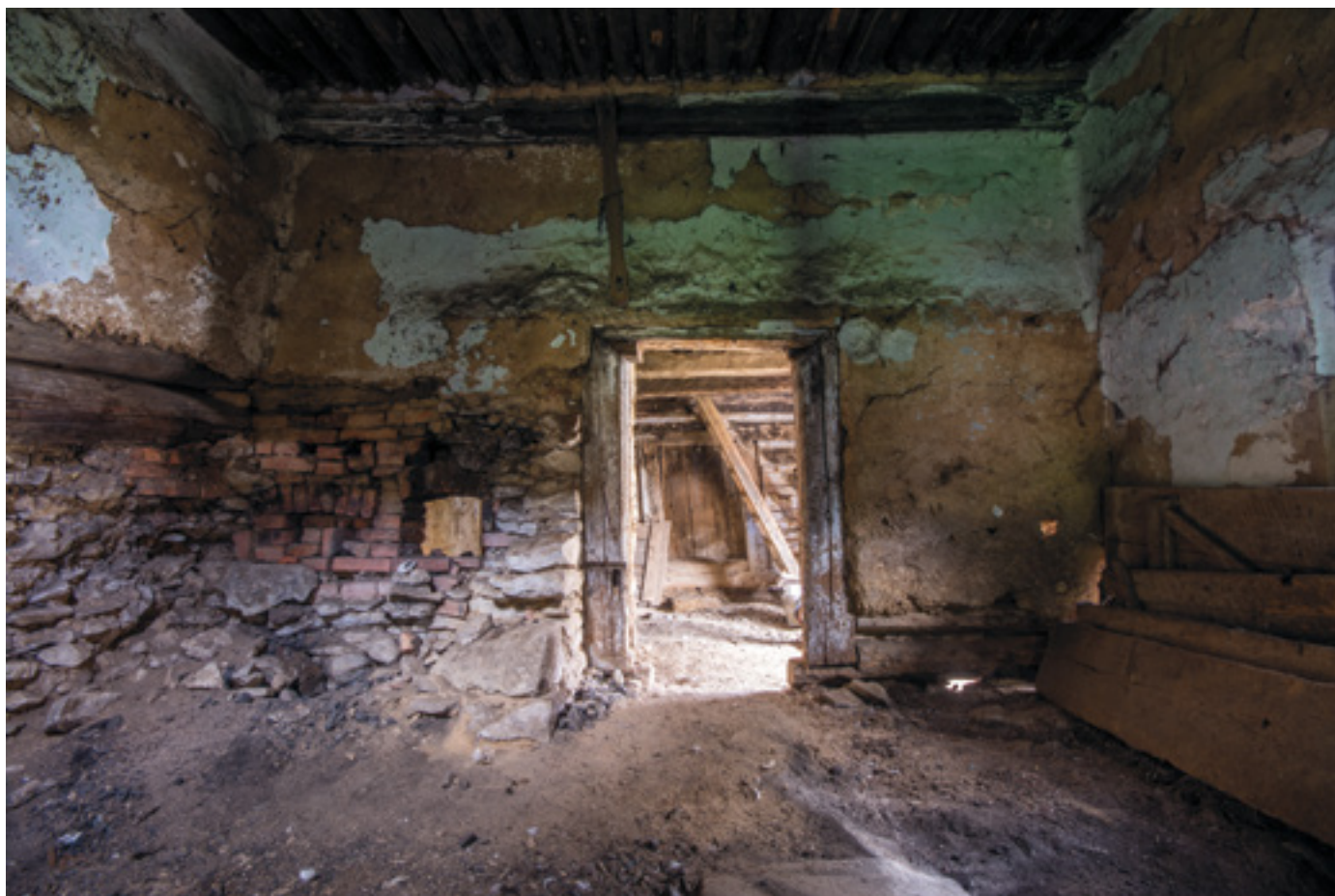
12. Světnice roubeného domu, pohled k jihovýchodu, 2015, foto J. Kmošek. Sitting room of the timbered house, view towards southeast. Stube des Blockhauses, Blick zum Südosten.
