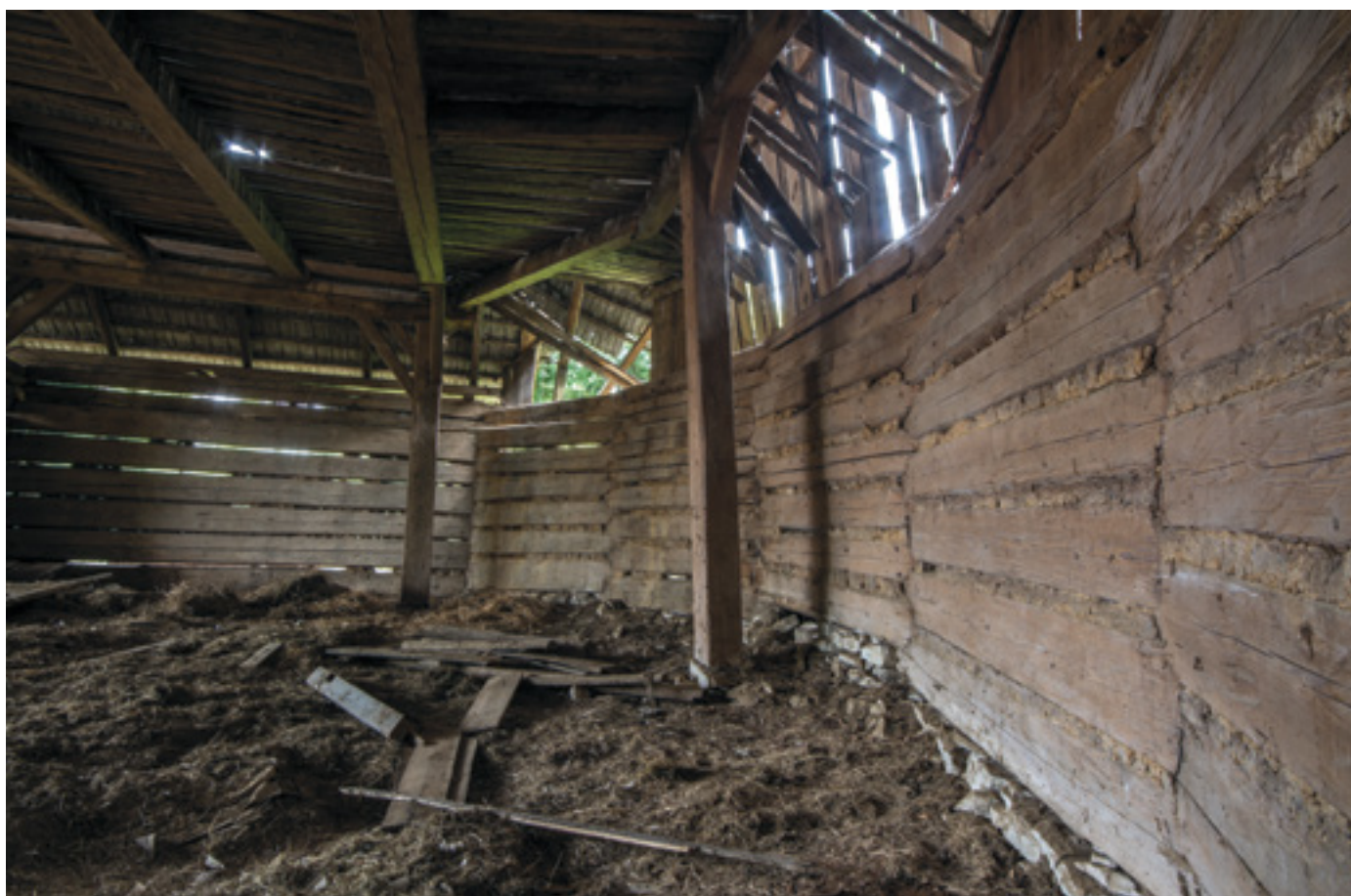
30. Roubení polygonu stodoly, pohled k severu, 2015, foto J. Kmošek. Timbering of the barn polygon, view towards north. Blockwände im polygonalen Abschluss der Scheune, Blick zum Norden.
