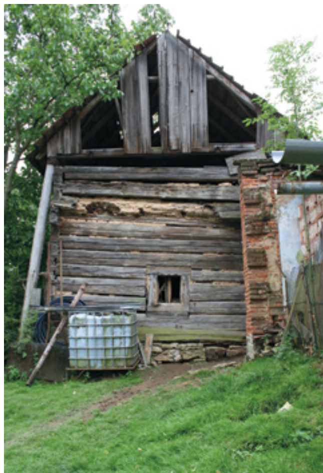
4. Severozápadní průčelí roubeného domu, 2015, foto V. Říhová. North-west facade of the timbered house. Nordwestliche Fassade des Blockhauses.
