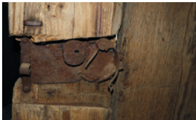
23. Detail zámku dveří výplně mezi komorou a síní v patře, 2015, foto Z. Křenková. Detail of the lock of the door panel between the chamber and the sitting room on the first floor. Detail des Schlosses vom Türblatt zwischen Kammer und Flur im ersten Stock.
