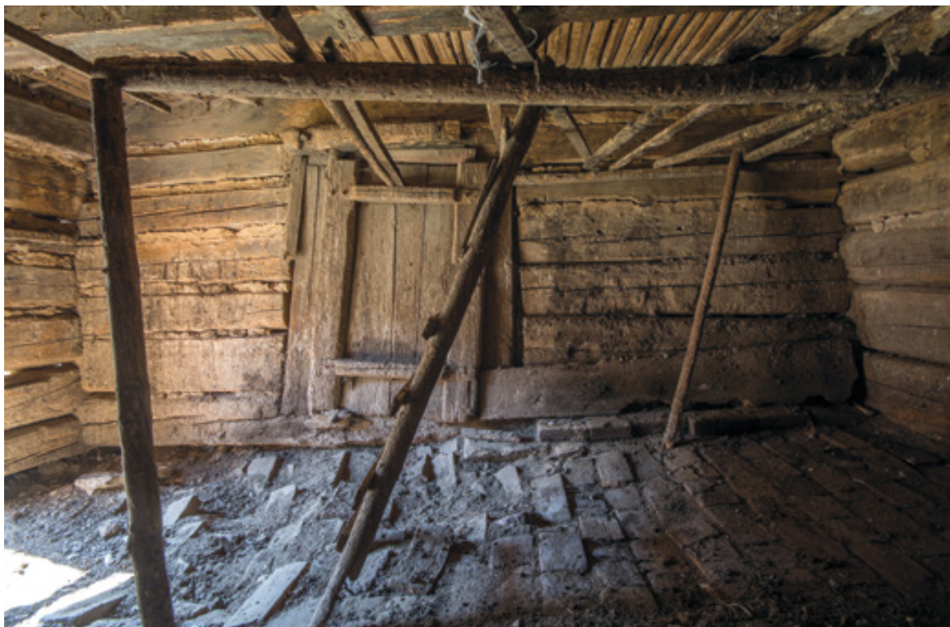
16. Stěna mezi síní a komorou v přízemí s původní dveřní výplní, pohled k severozápadu, 2015, foto J. Kmošek. Wall between the hall and the chamber on the ground floor with the original door panel, view towards northwest. Trennwand zwischen Flur und Kammer im Erdgeschoss mit ursprünglichem Türfeld, Blick zum Südwesten.
