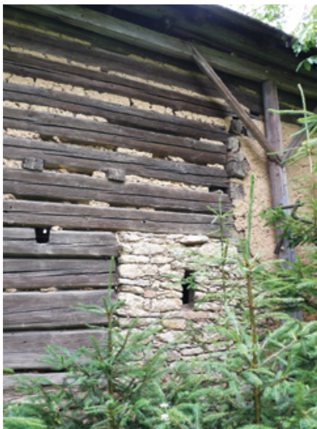
6. Detail severovýchodního průčelí roubeného domu, 2015, foto V. Řihová. Detail of the north-east facade of the timbered house. Detail der nordöstlichen Fassade des Blockhauses.
