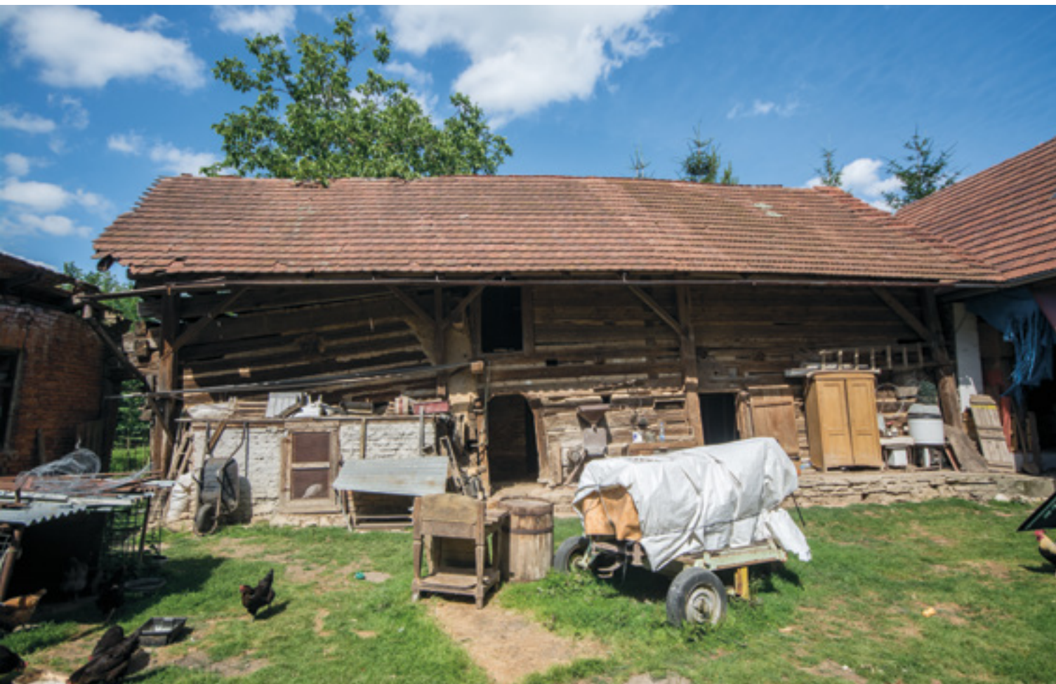
7. Jihozápadní průčelí roubeného domu, 2015, foto J. Kmošek. South-west facade of the timbered house. Südwestliche Fassade des Blockhauses.
