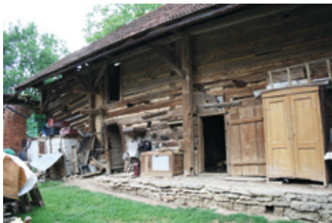
8. Detail jihozápadního průčelí roubeného domu, 2015, foto V. Říhová. Detail of the south-west facade of the timbered house. Detail der südwestlichen Fassade des Blockhauses.
