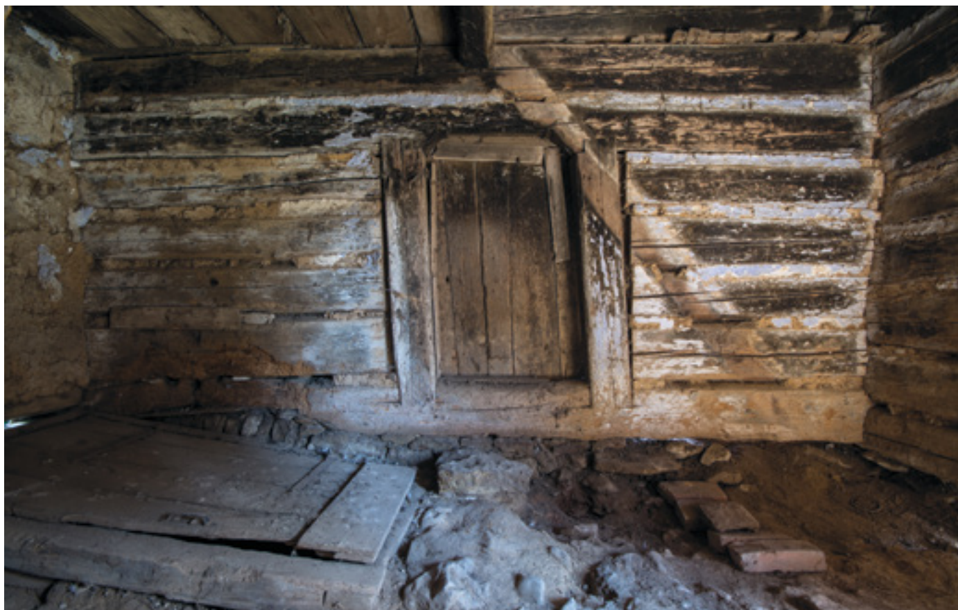
15. Stěna mezi síní a komorou v přízemí s původní dveřní výplní, pohled k jihovýchodu, 2015, foto J. Kmošek. Wall between the hall and the chamber on the ground floor with the original door panel, view towards southeast. Trennwand zwischen Flur und Kammer im Erdgeschoss mit ursprünglichem Türfeld, Blick zum Südosten.
