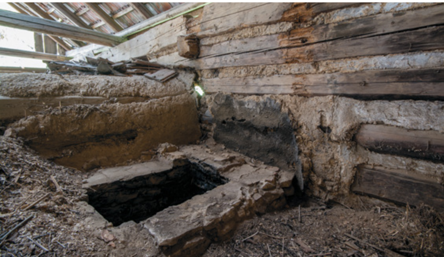
21. Sín v patře domu, otisk dymníku na severovýchodní stěně, 2015, foto J. Kmošek. Hall on the first floor of the house, an imprint of the chimney hood on the north-east wall. Flur im ersten Stock des Hauses, Abdruck des Rauchschlotts an der nordöstlichen Wand.
