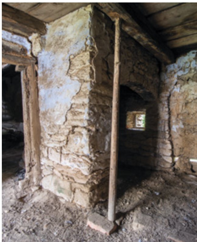
14. Obvodová stěna černé kuchyně v síni, pohled k severu, 2015, foto J. Kmošek. Perimeter wall of the smoke kitchen in the hall, view towards north. Umfassungsmauer der Rauchküche im Hausflur, Blick zum Norden.
