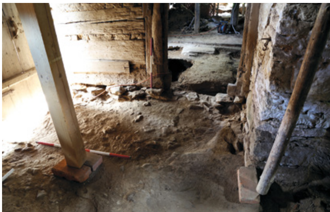
7. Prostor síně po primárním začištění, 2015, archiv Archaia Brno. The area of the hall after the primary evening. Stubenraum nach dem primären Putzen.
