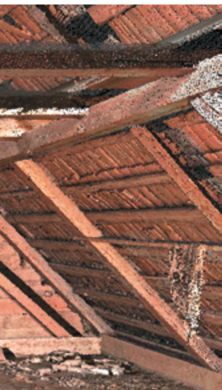
19. Prostorový model roubeného domu z Trstěnice, obarvené mračno bodů, 2015, vypracoval J. Kmošek. Three-dimensional virtual model of the timbered house from Trstěnice, coloured transparent point cloud. Raummodell vom Blockhaus aus Trstěnice, farbig gefasste Punktwolke.
