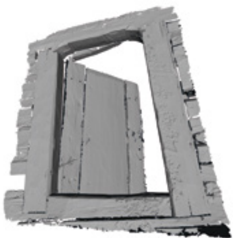
3. 3D model roubeného ostění dveří tvořený polygonovou sítí, 2015, vypracoval J. Kmošek. 3D model of the timbered door jambs in the form of a traverse net. 3D-Modell des gezimmerten Türstockes, bestehend aus einem Polygonnetz.
