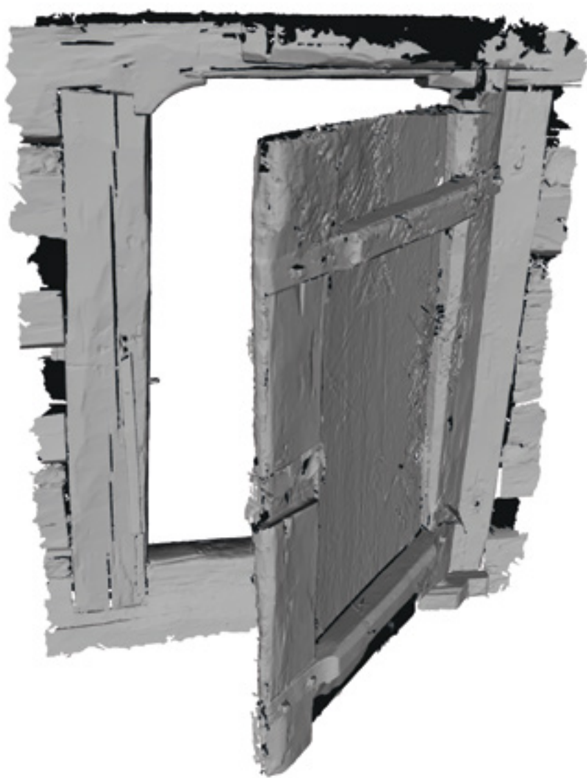
4. 3D model roubeného ostění dveří tvořený polygonovou sítí, 2015, vypracoval J. Kmošek. 3D model of the timbered door jambs in the form of a traverse net. 3D-Modell des gezimmerten Türstockes, bestehend aus einem Polygonnetz.
