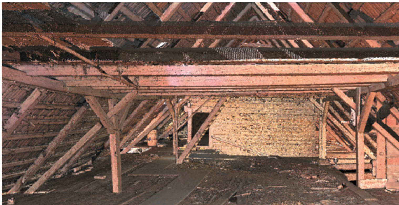
18. Prostorový model roubeného domu z Trstěnice, obarvené průhledné mračno bodů, 2015, vypracoval J. Kmošek. Three-dimensional virtual model of the timbered house from Trstěnice, coloured transparent point cloud. Raummodell vom Blockhaus aus Trstěnice, farbig gefasste durchsichtige Punktwolke.
