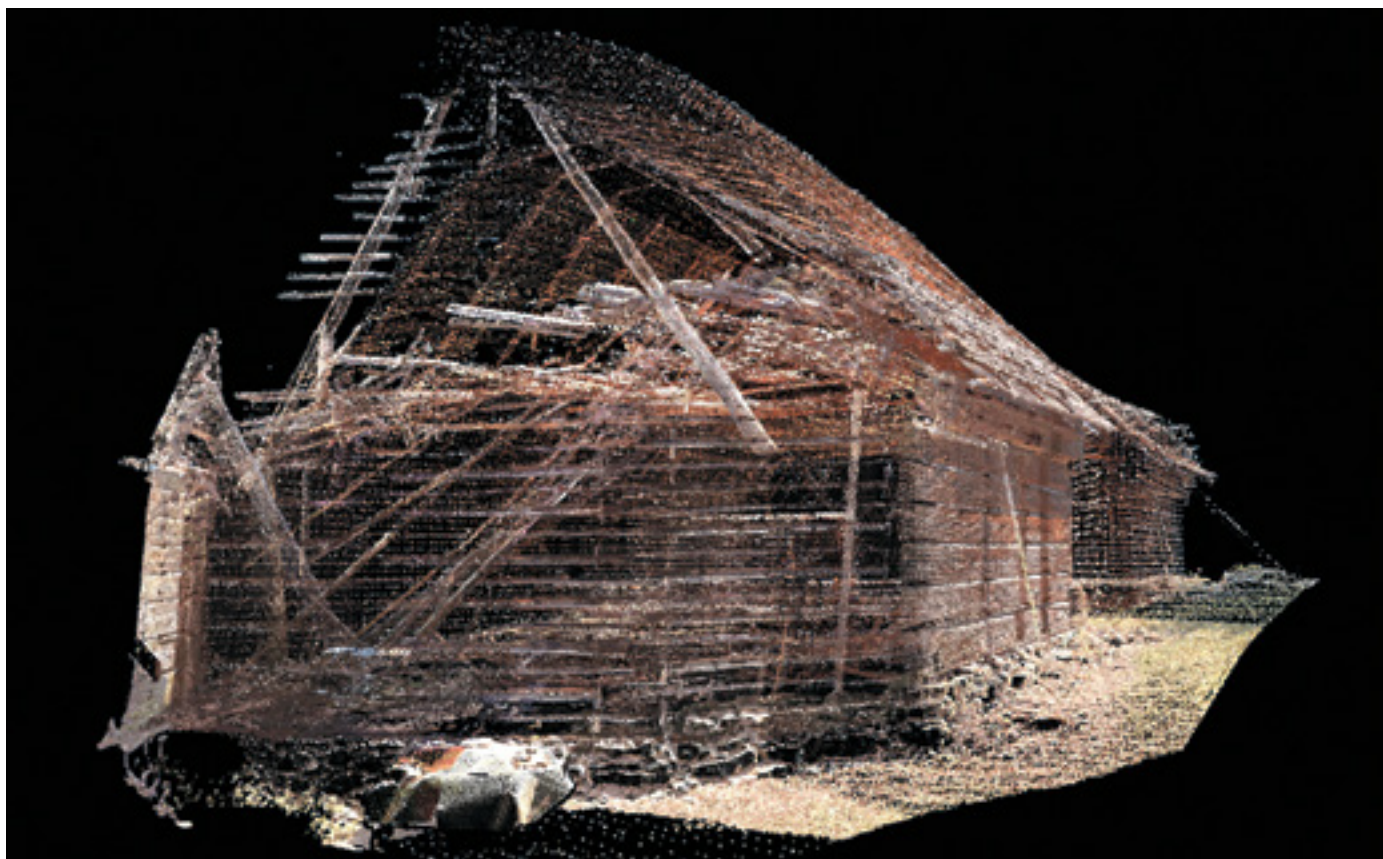
9. Prostorový model polygonální stodoly v Čisté, obarvené průhledné mračno bodů, 2015, vypracoval J. Kmošek. Three-dimensional virtual model of the polygonal barn in Čistá, coloured transparent point cloud. Raummodell der polygonalen Scheune in Čistá, farbig gefasste durchsichtige Punktwolke.
