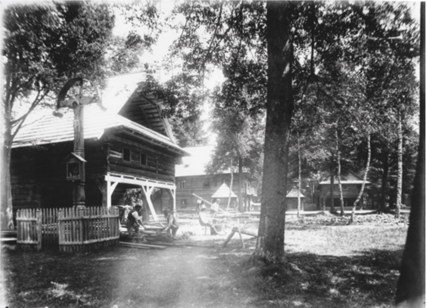
2. Stavba Vaškovy hospody z rožnovského náměstí v Dřevěném městečku. Řemeslníci pracují ručními nástroji. Patrných je mnoho výměn, prvky podsíně jsou oproti stavu na náměstí zdobnější, zhlaví trámů jsou zkrácena. 1928, pohlednice, oddělení dokumentace VMP. The construction of Vašek's Pub from the Rožnov square in the Wooden Town. The craftsmen are working with manual tools and instruments. Many changes are obvious: the arcade elements are more decorative than the ones in the square, the beam heads are shortened. Errichtung des Gasthauses Beim Wenzel, ursprünglich vom Marktplatz in Rožnov pod Radhoštěm, im sog. Holzstädtchen. Die Handwerker arbeiten mit Handwerkzeugen. Zu sehen sind viele ausgetauschte Teile, die Elemente der Vorlaube sind im Unterschied zum Originalbau vom Marktplatz mehr geziert, die Balkenköpfe wurden gekürzt.
