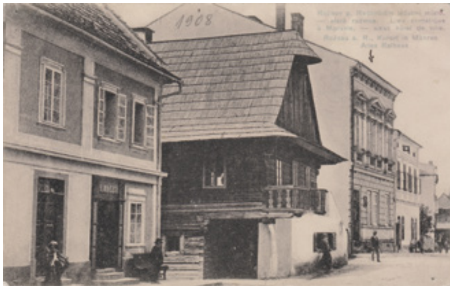
1. Stará radnice v původním stavu na rožnovském náměstí kolem roku 1908 má zvětšená okna, podezděnou pavlač s krámkem a jednoduchý bedněný štít. Při transferu byla okna zmenšena a proveden zdobný štít, sloupy pavlače byly rekonstruovány již před transferem. Pohlednice, oddělení dokumentace VMP. Old town hall in its original state in the town square of Rožnov around 1908; it has enlarged windows, an underpinned courtyard balcony with a shop and a simple boarded gable. The windows were reduced and a decorated gable made during the transfer. The pillars of the courtyard balcony had been reconstructed before the transfer. Das alte Rathaus auf dem Marktplatz in Rožnov pod Radhoštěm im ursprünglichen Zustand, aufgenommen um 1908. Das Haus hat vergrößerte Fenster, eine untermauerte Laube mit einem Laden und einen einfachen verschalteten Giebel. Anlässlich der Transferierung wurden die Fenster verkleinert und der Giebel geschmückt, die Laubensäulen wurden bereits vor der Transferierung erneuert.
