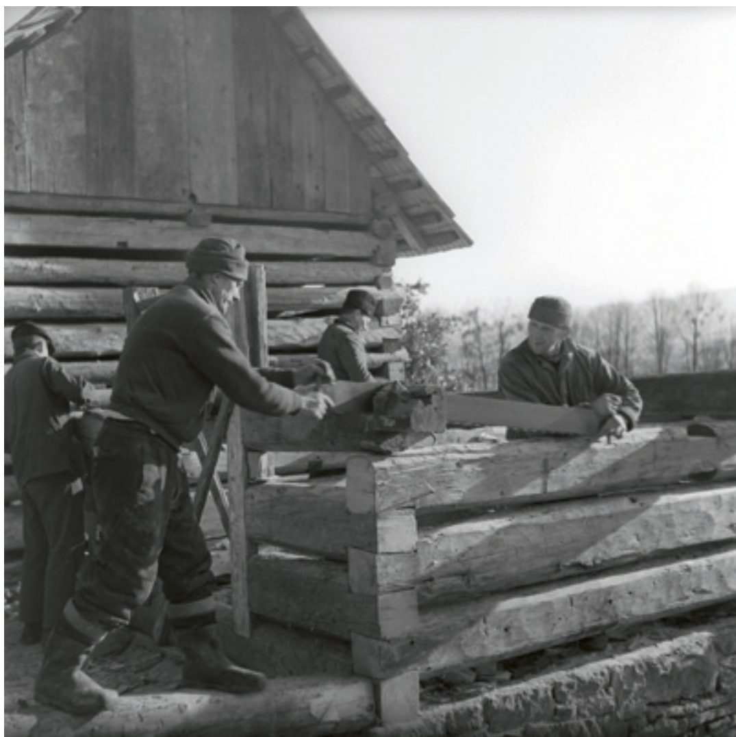
9. Chalupa z Leskovce, při stavbě jsou využívány starší prvky z materiálových rezerv i nové prvky, vyniká ruční práce. 1963, foto V. Bulavová, oddělení dokumentace VMP. Cottage of a landless person from Leskovce. Older elements from the material reserves as well as new elements were used during the construction, outstanding manual work. Das Haus eines Landlosen aus Leskovce, beim Wiederaufbau wurden sowohl ältere Bauelemente aus den Materialvorräten wie auch neue Teile benutzt, ausgezeichnete Handarbeit.
