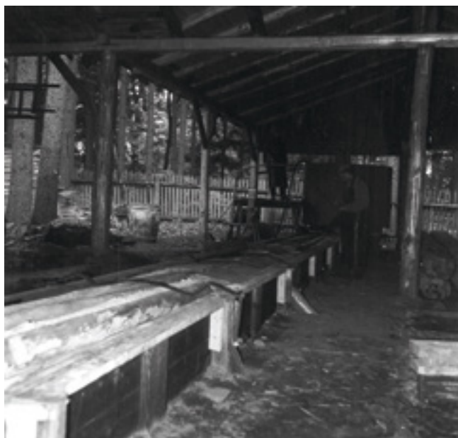
5. Oplechované dřevěné konzervační koryto pod přístřeškem v Dřevěném městečku, máčené prvky jsou zajištěny pásovinou. 1963, foto V. Bulawová, oddělení dokumentace VMP. Wooden conservation trough covered with sheet metal under a shelter in the Wooden Town. The soaked elements are fastened by straps. Hölzerne, mit Blech beschlagene Konservierungsrinne unter einem Schutzdach im sog. Holzstädtchen, die eingetauchten Elemente wurden mittels Flachstall gesichert.
