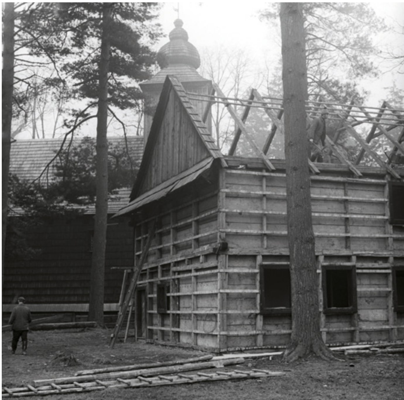
3. Billův měšťanský dům, pro rekonstrukci zadní části stavby byla po transferu v roce 1925 použita provizorní rámová konstrukce. 1972, foto B. Příkryl, oddělení dokumentace VMP. Bill's townhouse; a provisional frame construction was used to reconstruct the rear part of the building after the transfer in 1925. Bills Bürgerhaus, der Hinterteil des Hauses wurde nach der Transferierung im Jahre 1925 mittels der provisorischen Rahmenkonstruktion rekonstruiert.
