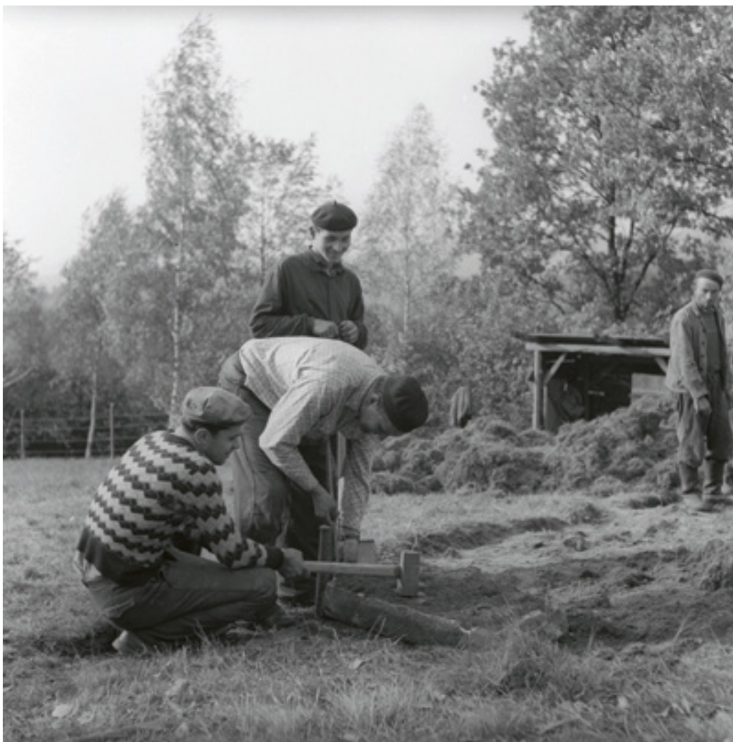
7. Zakládání chalupy z Miloňova na Valašské dědině přímo na srovnaný terén, ohnutý muž je mistr stavební skupiny JZD Velké Karlovice Ludvík Holčák. 1962, foto V. Bulavová, oddělení dokumentace VMP. Laying of the foundations of a cottage from Miloňov in the Wallachian Village directly on the levelled terrain; the bent man is Ludvík Holčák, foreman of the building group of the collective farm Velké Karlovice. Die Gründung des Bauernhauses aus Miloňov im sog. Walachischen Dorf auf eingeebnetem Terrain, der sich bückende Mann ist der Meister der Bautruppe aus der Agrargenossenschaft Velké Karlovice Ludvík Holčák.
