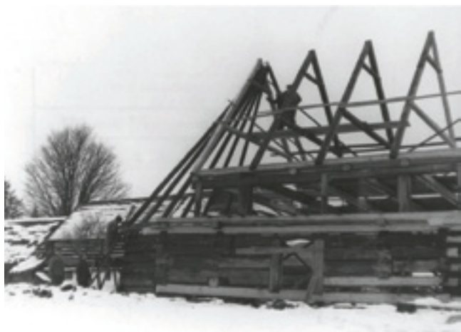
5. Rekonstrukce polygonální stodoly na Veselém Kopci, 1973, foto L. Černík, fotoarchiv SLS Vysočina. Reconstruction of the polygonal barn at Veselý Kopec in 1973. Wiederaufbau der polygonalen Scheune im Freilichtmuseum Veselý Kopec im Jahre 1973.
