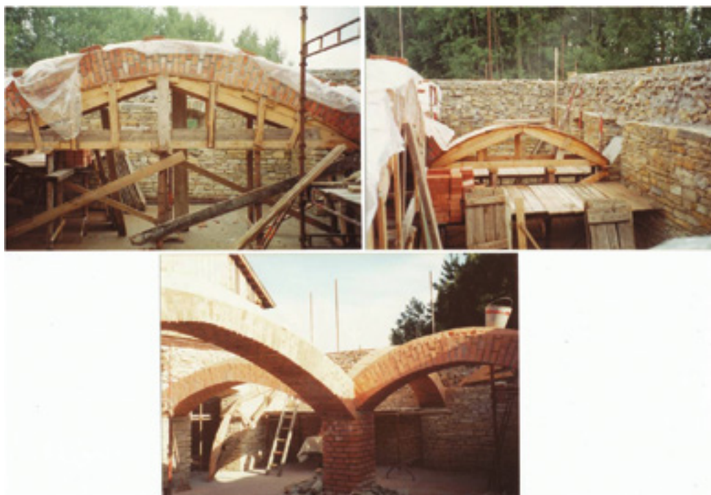
23. Kopie chlívů – klenutí pruské placky na středový sloup, 2000, foto J. Häuszler, fotoarchiv SLS Vysočina. Copy of the cowsheds – vaulted “Prussian cake” based on a central column. Kopie der Ställe – die Preußischen Kappen werden vom Mittelpfosten unterstützt.
