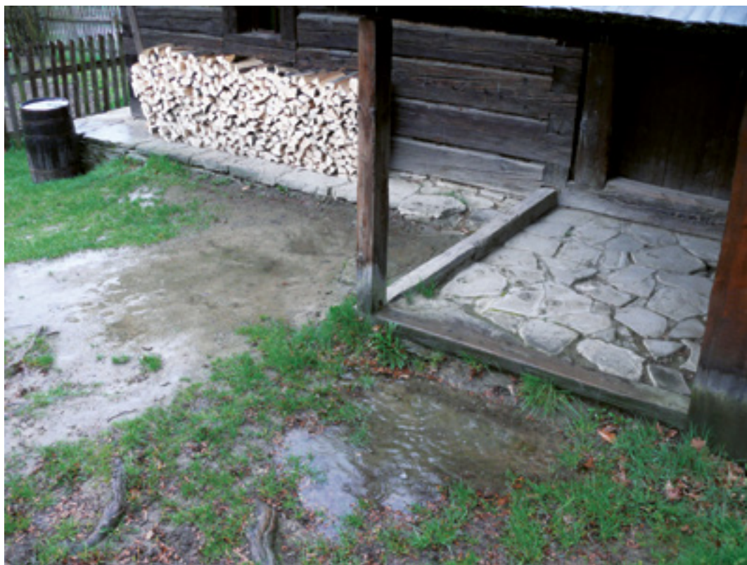
9. Základní ochranou stavebních památek by měla být vhodná úprava terénu zamezující přístupu vlhkosti, 2015, foto R. Bryol, Oddělení dokumentace VMP. The basic protection of monuments should have the form of appropriate landscaping in order to prevent moistening. Zu den grundlegenden Schutzmaßnahmen der Bauwerke sollte die passende Aufbereitung des Geländes gehören, wodurch das Übergreifen von Feuchtigkeit auf die Objekte vermieden wird.
