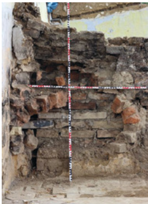
13. Dům s podsíní čp. 65 v Oskořínku, prostor topeniště, torzo kapkovité pece s druhotnou vyzdívkou, fotografický podklad pro zpracování fotometrické dokumentace, červen 2015, foto A. Rákosníková, NPÚ ÚOP SČ. House with arcade No. 65 in Oskoříněk, the fireplace area, the torso of a drop-shaped oven with secondary lining, photographic material used for the preparation of photometric documentation. Vorlaubenhaus Nr. 65 in Oskoříněk, Feuerstelle, Torso des tropfenförmigen Ofens mit sekundärer Ausmauerung, fotografische Unterlage für die Ausarbeitung der fotometrischen Dokumentation.
