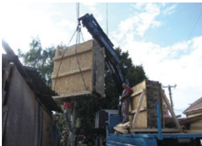
16. Dům čp. 65 v Oskořínku, přenesení dvou kompaktních bloků zdiva z nepálených cihel pomocí jeřábu z původního místa na nákladní auto, září 2015, foto M. Hanzlíková, NPÚ ÚOP SČ. House No. 65 in Oskoříněk, the transfer of two compact blocks of masonry from the original place onto a lorry using a crane. Haus Nr. 65 in Oskoříněk, Transferierung der zwei kompakten Mauerwerkblöcke aus luftgetrockneten Ziegeln mithilfe eines Krans vom ursprünglichen Aufstellungsort auf den Lastkraftwagen.
