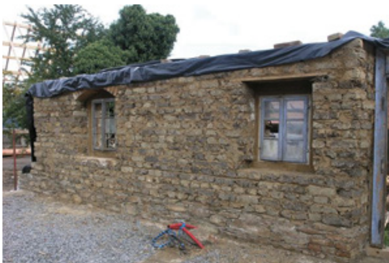
15. Přerov nad Labem, nově vyzdžené dvorní průčelí domu s podsíní čp. 65 z Oskořínku z přenesených nepálených cihel, pohled z interiéru, září 2015, foto M. Hanzlíková, NPÚ ÚOP SČ. Přerov nad Labem, the courtyard facade of house with arcade No. 65 from Oskoříněk newly lined with transferred unfired bricks, view from the interior. Přerov nad Labem, die unter der Verwendung von transferierten Lehmziegeln neu gemauerte Hoffassade des Vorlaubenhauses Nr. 65 aus Oskoříněk, Ansicht vom Hausinneren.
