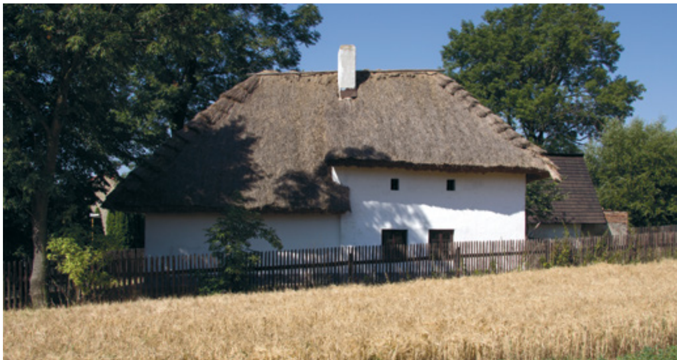
1. Dům čp. 65, Hejnice v Rymicích, 2015, foto R. Bašta, fotoarchiv MK. House No. 65, Hejnice in Rymice. Haus Nr. 65, Hejnice in Rymice.
