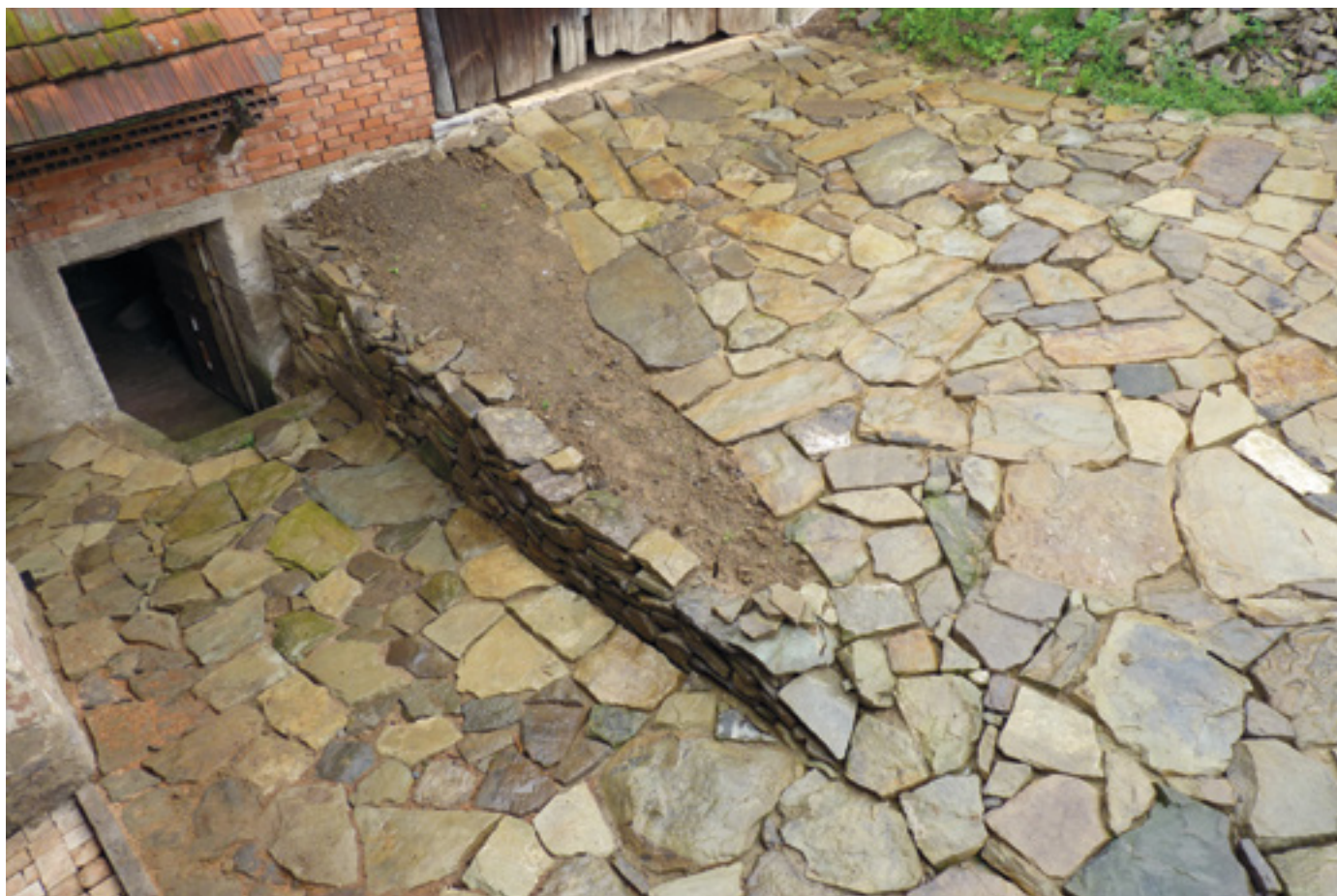
12. Dlažba dvora, 2011, foto V. Říhová. Courtyard paving. Pflasterung im Hof.
