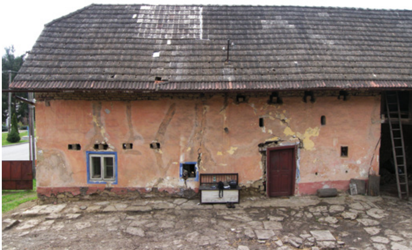
2. Obytný dům – dvorní fasáda před započatím obnovy, 2010, foto V. Říhová. Residential house – courtyard facade before the beginning of the reconstruction. Wohnhaus – Hoffassade vor der Erneuerung.
