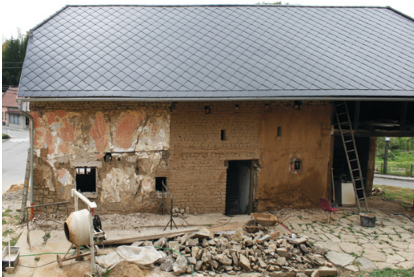
8. Obytný dům – přezdění části obvodového zdiva, 2012, foto V. Říhová. Residential house – re-bricking of a part of the outside walls. Wohnhaus – Wiedervermauern eines Teils vom Umfassungsmauerwerk.
