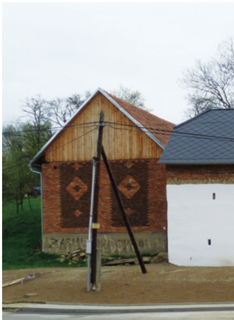
14. Celkový pohled na usedlost po dokončení obnovy – vlevo stodola, ve středu obytný dům, vpravo výměnek, 2013, foto V. Říhová. Overall view of the farmstead after the reconstruction – barn on the left, residential house in the middle, reservatum rusticum on the right. Gesamtansicht des Bauerhauses nach der Erneuerung – links die Scheune, in der Mitte das Wohnhaus, rechts das Ausgedinge.
