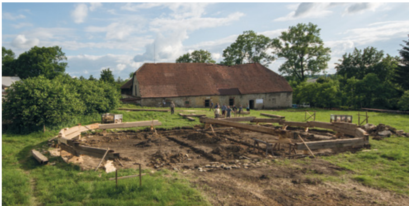
10. Montáž polygonální stodoly na pozemcích přiléhajících k usedlosti čp. 56 v Trstěnici, 2016, foto J. Kmošek. Assembly of the polygonal barn on the premises of farmstead No. 56 in Trstěnice. Aufbau der polygonalen Scheune auf dem Grundstück des Bauernhofes Hs.-Nr. 56 in Trstěnice.
