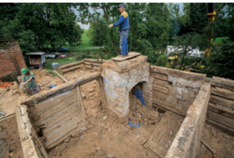
1. Průběh demontáže roubenného domu čp. 97 v Čistě, 2015, foto J. Kmošek. The course of the disassembly of timbered house No. 97 in Čistá. Verlauf des Abbaus vom Blockhaus Hs.-Nr. 97 in Čistá.
