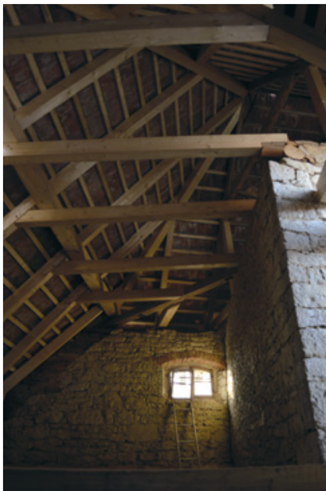
11. Obnovený krov a střecha nad jihozápadním nárožím, usedlost čp. 56 v Trstěnici, 2016, foto V. Kmošek. Restored truss and roof above the south-west corner, farmstead No. 56 in Trstěnice. Der erneuerte Dachstuhl und das Dach über der südwestlichen Ecke, Bauernhof Hs.-Nr. 56 in Trstěnice.
