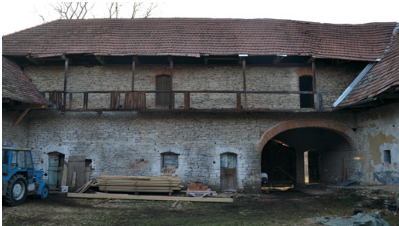
4. Západní stěna dvora, usedlost čp. 56 v Trstěnici, 2015, foto V. Kmošek. Westwand des Hofes, Bauernhof Hs.-Nr. 56 in Trstěnice.
