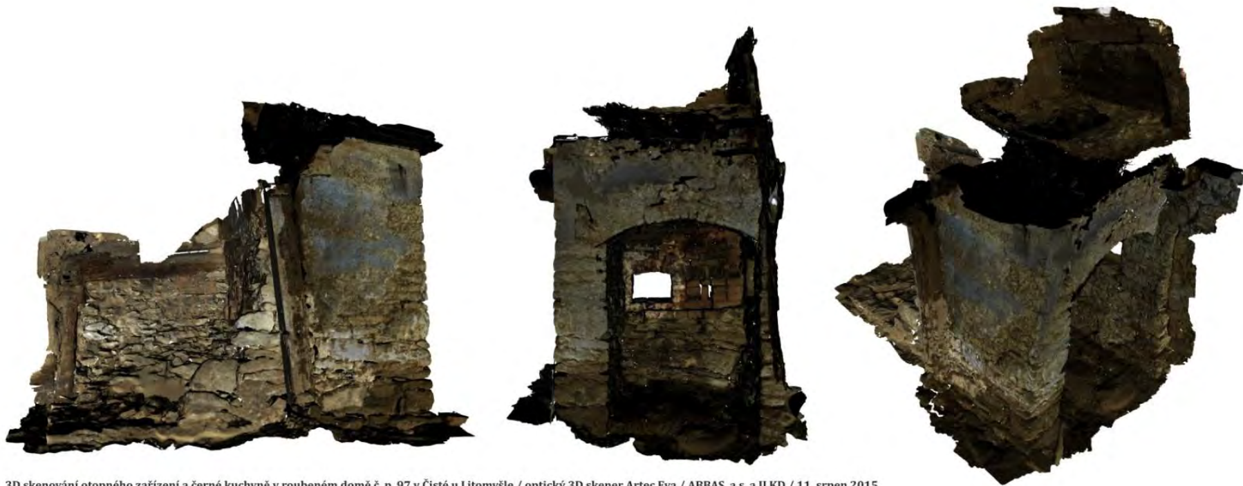
3D skenování otopného zařízení a černé kuchyně v roubeném domě č. p. 97 v Čisté u Litomyšle / optický 3D skener Artec Eva / ABBAS, a.s. a ILKD / 11. srpen 2015
